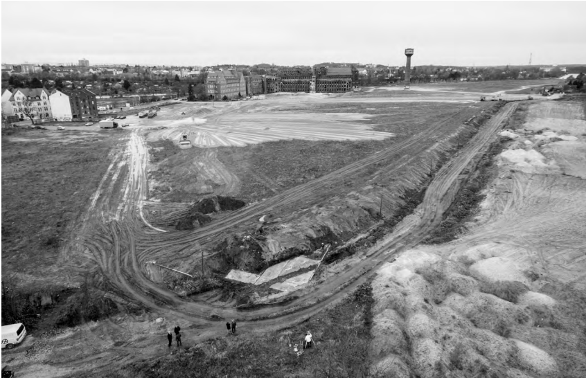
Blick nach Westen auf das ehemalige KZ- und Werksgelände der Continental, November 2015. Im Vordergrund ist der teilweise freigelegte Boden der östlichen Häftlingsbaracke zu sehen.
