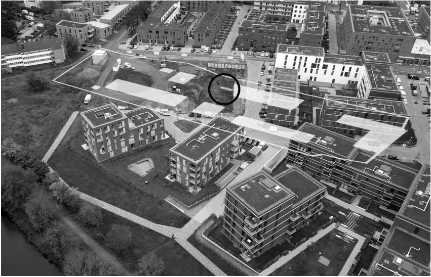
Blick auf das ehemalige KZ-Gelände in Richtung Südosten, Oktober 2024, mit ungefährender Lage der Baracken und der Umzäunung. Im Kreis: Reste der westlichen Häftlingsbaracke, die bei Bauarbeiten für wenige Tage freigelegt und archäologisch dokumentiert wurden.
