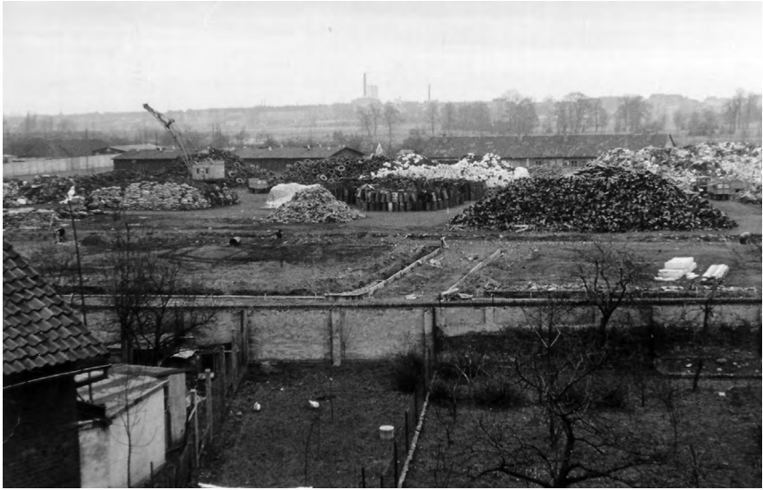
Blick aus dem 2. Stock des Hauses Wunstorfer Straße 96 nach Norden auf das ehemalige KZ-Gelände, März 1959. Die beiden Häftlingsbaracken des KZ stehen noch, davor befindet sich ein Altreifenlager der Continental.
