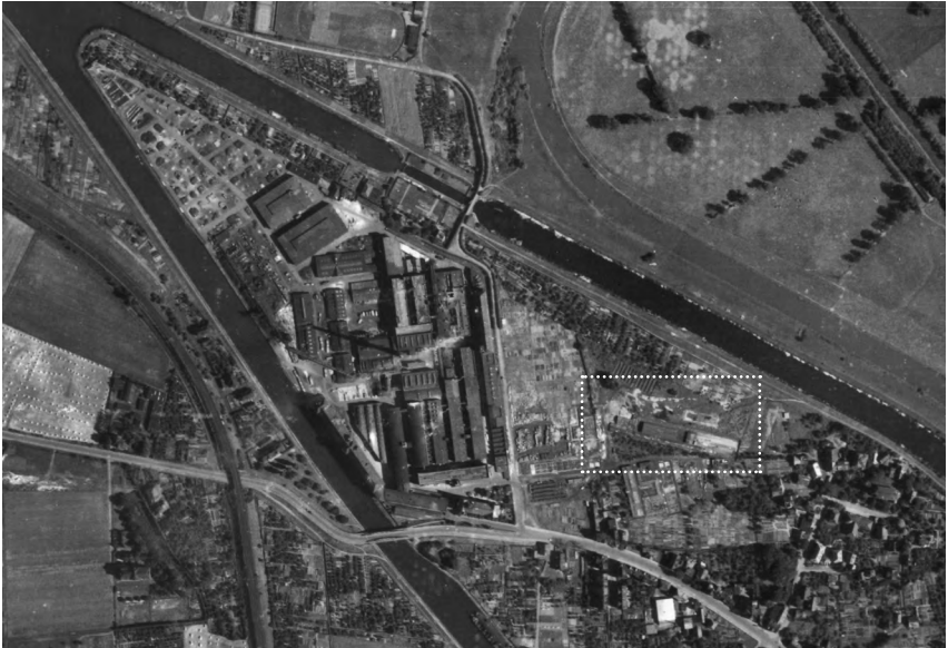
Luftbild des Continental-Werks Limmer vom 4. August 1944 mit dem ersten Bauabschnitt des Konzentrationslagers. Unten verläuft die Wunstorfer Straße, rechts unten im Bild ist der alte Dorfkern von Limmer zu sehen.
